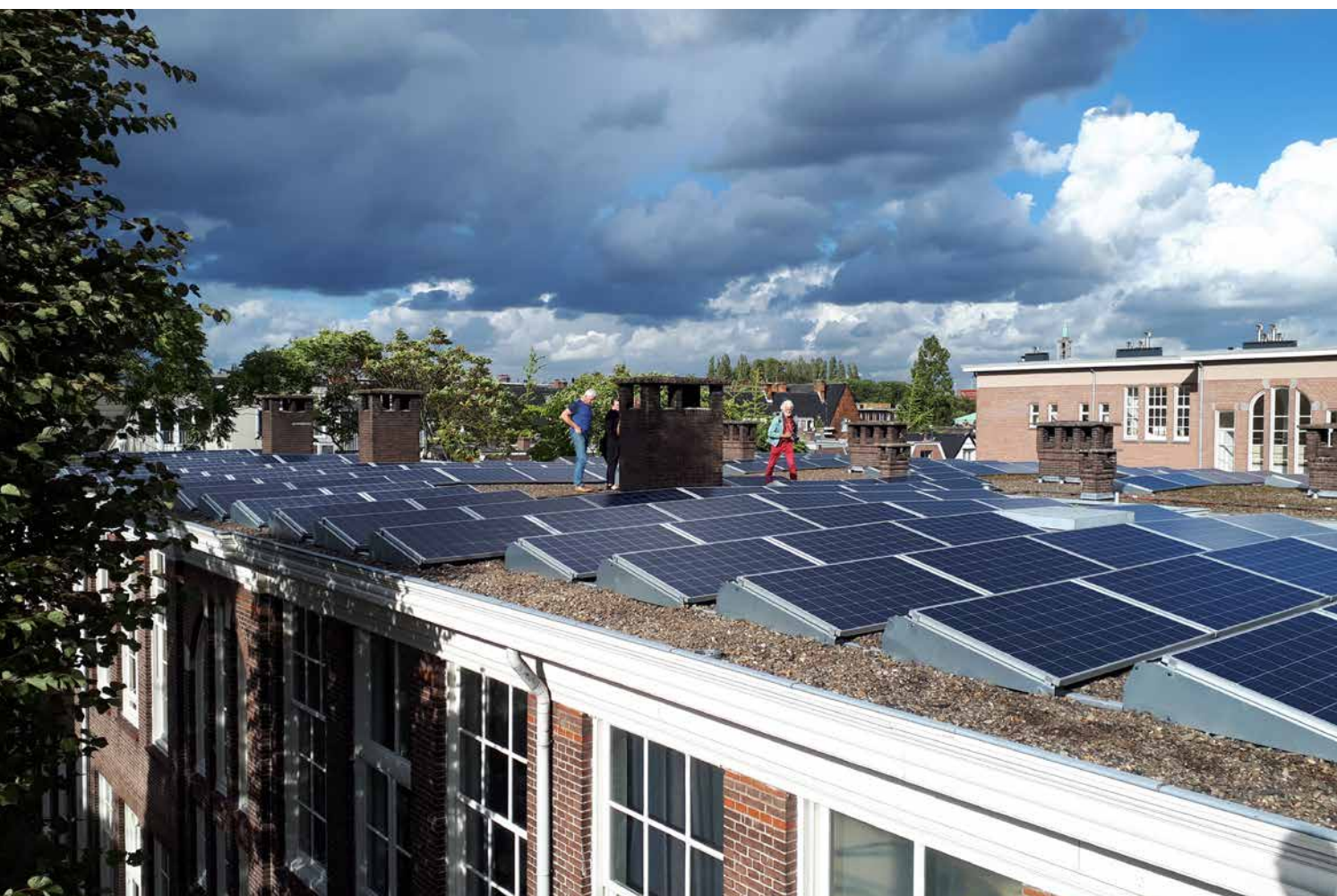
Collectief zonnedak van energiecoöperatie Blijstroom in Rotterdam Noord
