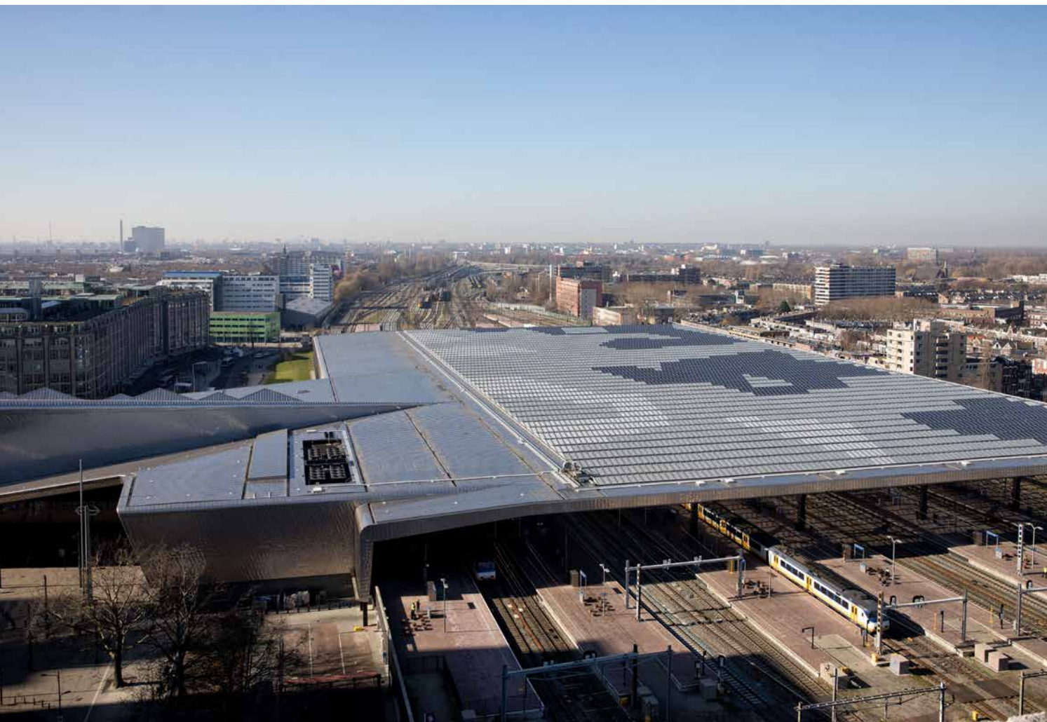
Zonnepanelen op dak van Centraal Station Rotterdam
