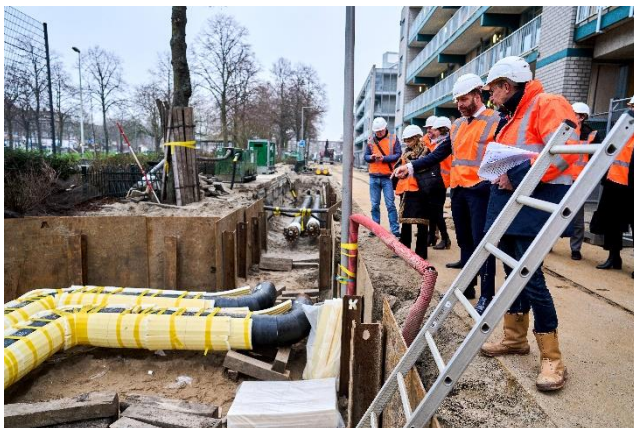
Afbeelding: de buizen voor stadsverwarming worden in de straat gelegd. Vorig jaar zijn we daar stap voor stap mee begonnen. Foto: Phil Nijhuis
