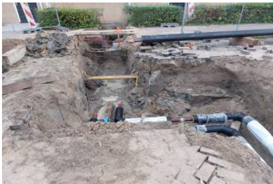
Aanleg warmtenet De Schuilburg oktober 2023
